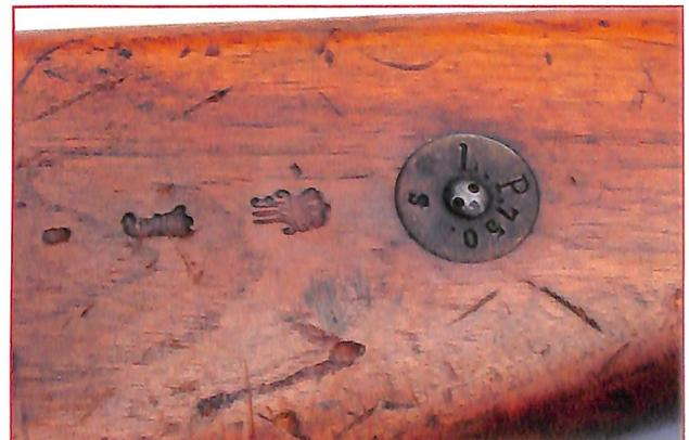
Stempelplatte mit Abnahmestempel und Herrschermonogramm im Kolben des Schutztruppengewehres 98 der Landpolizei in DSWA.
